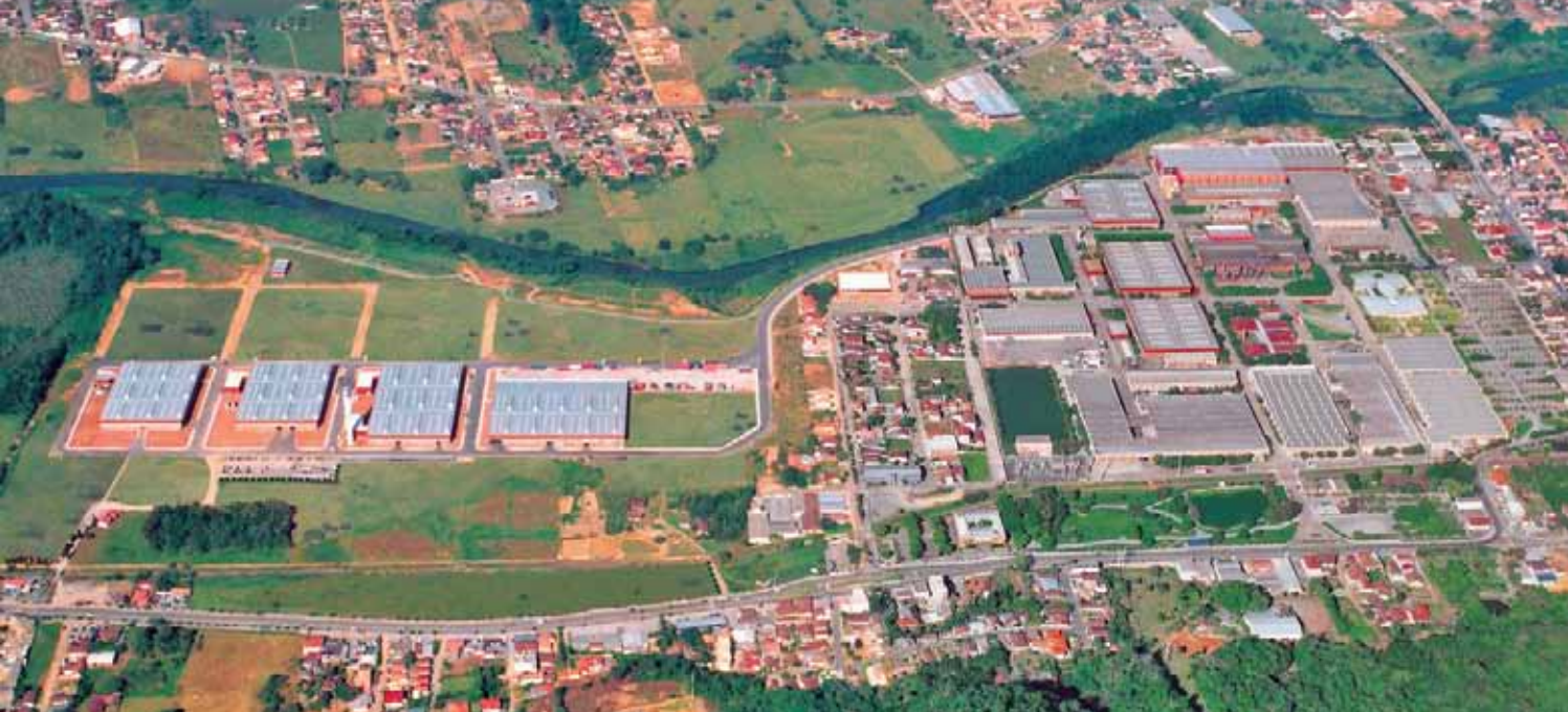
Vista aérea da WEG em Jaraguá do Sul: mais de 2 quilômetros de extensão
